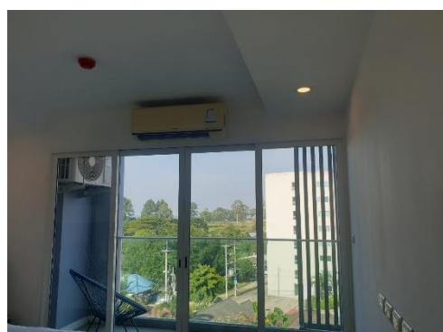
รูปที่ 3-22 การใช้กระจกตัดแสง โทนสีอ่อนของอาคาร และการระบายอากาศโดยวิธีธรรมชาติของอาคาร
