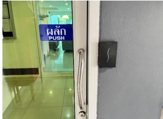
รูปที่ 3-39 ติดตั้งระบบ access control ด้วยระบบ keycard บริเวณประตู ทางเข้า-ออกอาคาร
