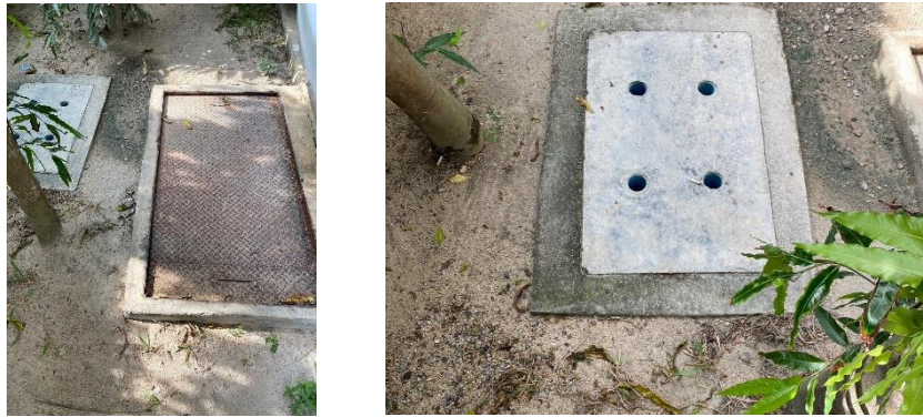
รูปที่ 3-18 บ่อหน่วงน้ำและบ่อพักน้ำ
