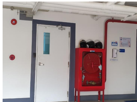
รูปที่ 3-28 อุปกรณ์แจ้งเหตุไฟไหม้กริ่งส่งสัญญาณเตือนอัคคีภัย (Fire Alarm Bell) และแผงควบคุม (Manual Station)
