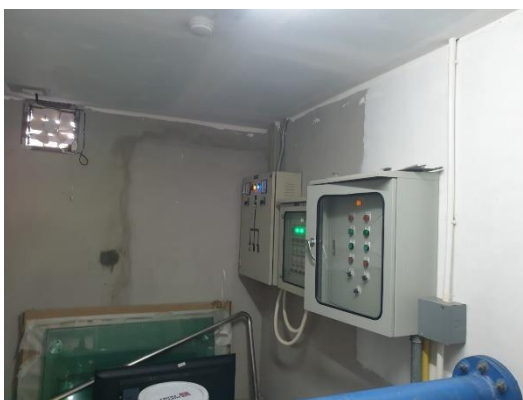
รูปที่ 3-8 ระบบควบคุมและระบบบำบัดน้ำเสีย
