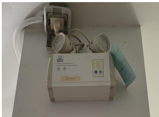
รูปที่ 3-27 อุปกรณ์ตรวจจับควัน ตรวจจับความร้อน และไฟฉุกเฉินอัตโนมัติชนิดแบตเตอรี่แห้ง
