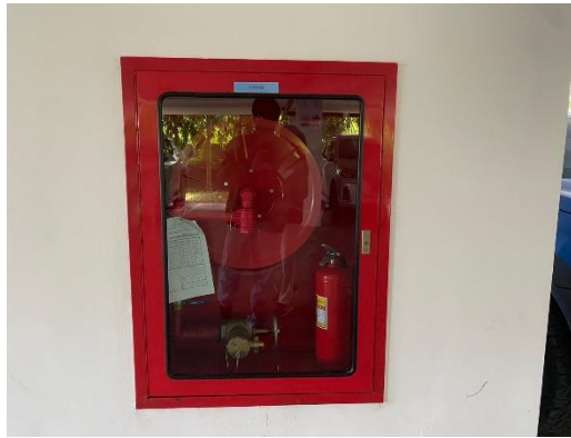
รูปที่ 3-26 ตู้เก็บสายฉีดน้ำดับเพลิงพร้อมอุปกรณ์ (Fire Hose Cabinet : FHC)
